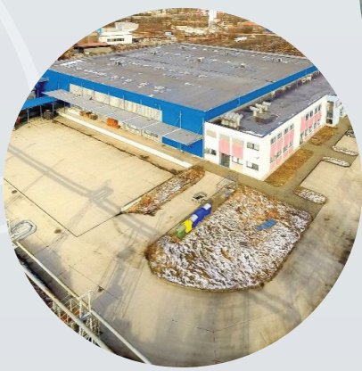
Производственный и монтажный цех компании PRAKTIKPUMP, s.r.o.
